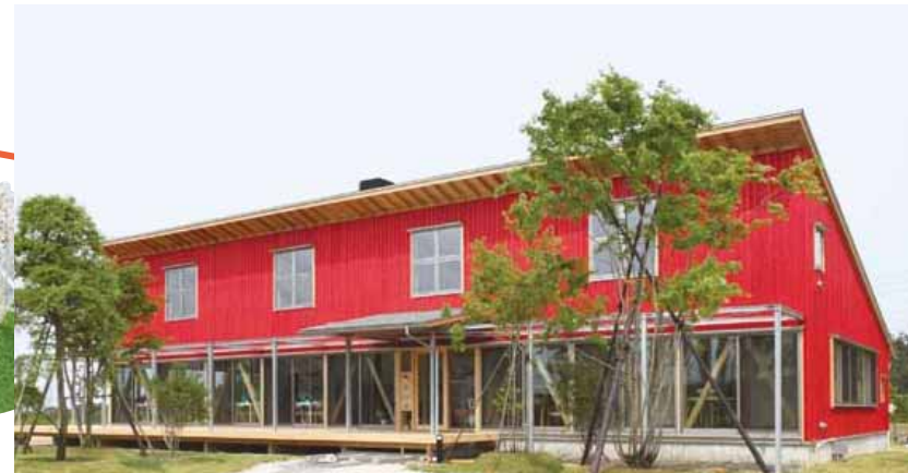
センター棟 真っ赤な外観が目目をひくセンター棟は、「ピュアヴィレッジ」のシンボル。1階は室内に光を多く取り入れられるよう、全面ガラス張りになっています。年間を通じて各種セミナーなども開かれます。
