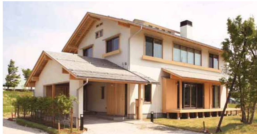
展示場 周囲の街並みと調和のとれたシンプルな外観の長岡展示場。「ピュアの家」の特徴でもある小さな越屋根は、「夏涼しく、冬暖かい」一年中快適な室内環境を保つためのもの。
